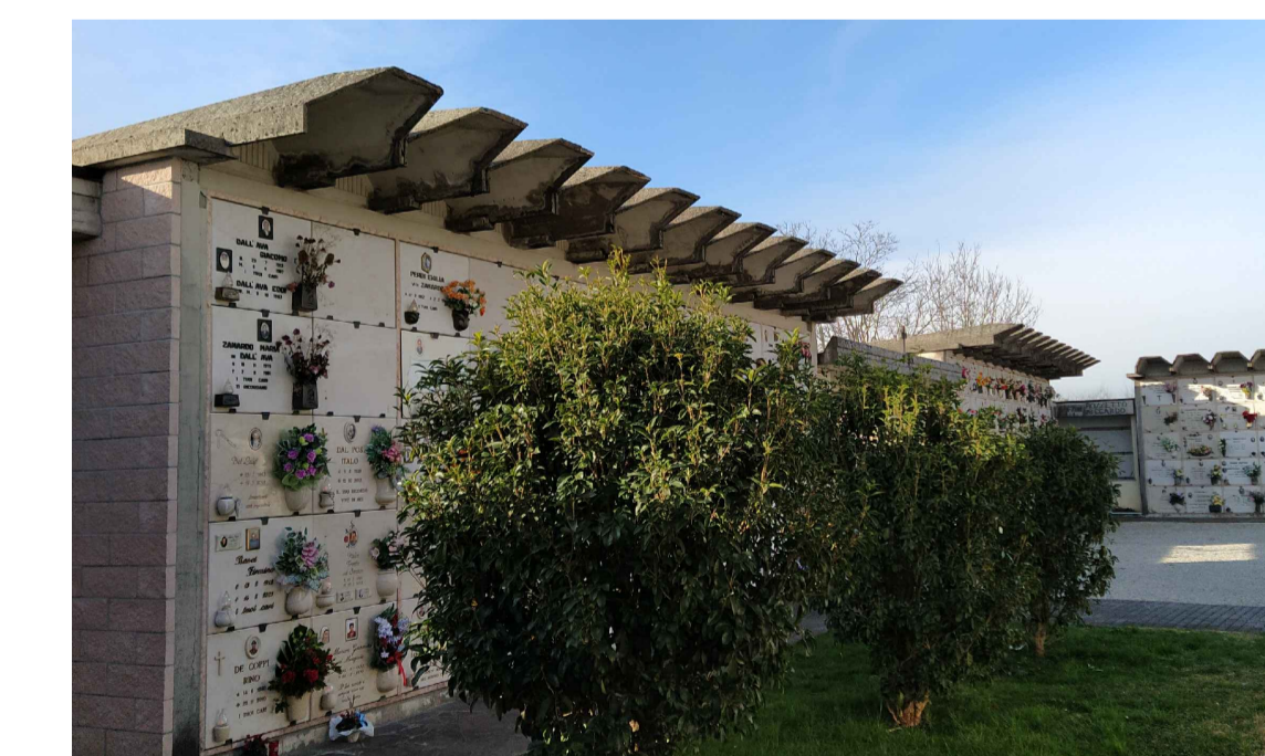
FOTO ELEMENTI IN CLS
