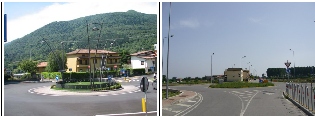
Figura 2.9 - Impianti di rotatorie conformi alla L.r.17/09 con apparecchi stradali posti centralmente o esternamente.
